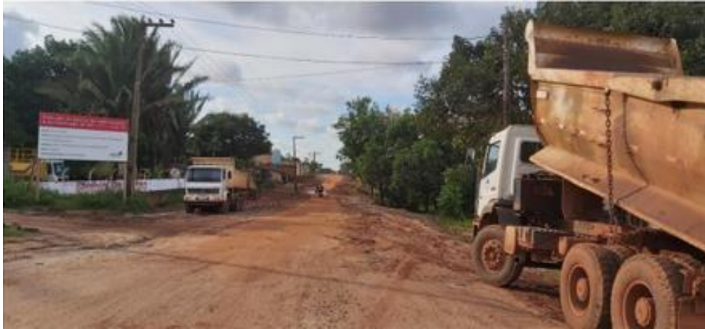
IMAGEM 2: Construção da rodovia MA-211 sobre o território quilombola Ramal de Quindíua
