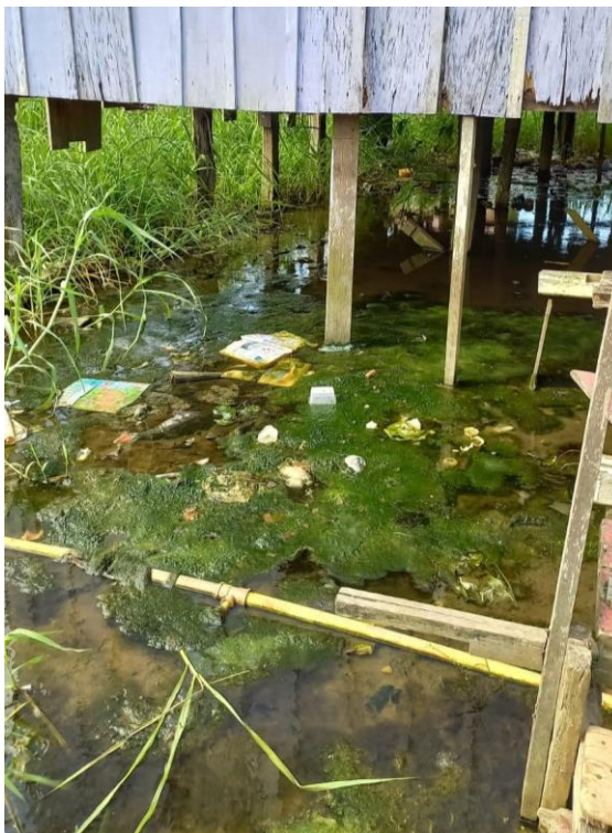
Imagem 2- Falta de saneamento na localidade do Portinho
