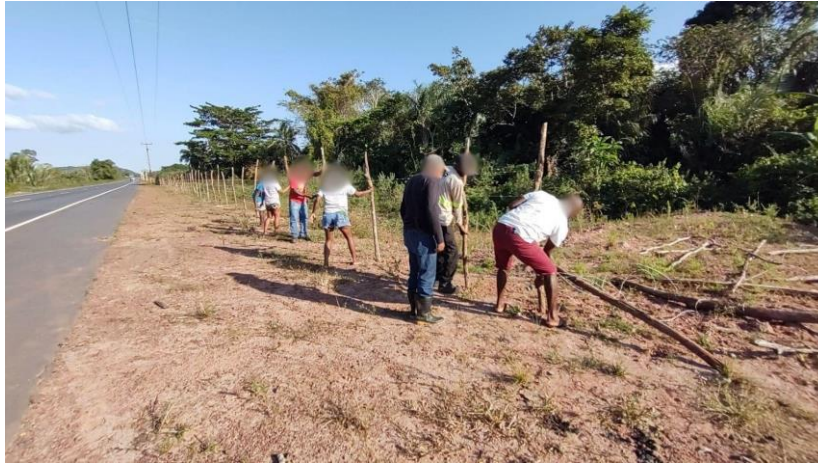
IMAGEM 9: Derrubada da cerca
