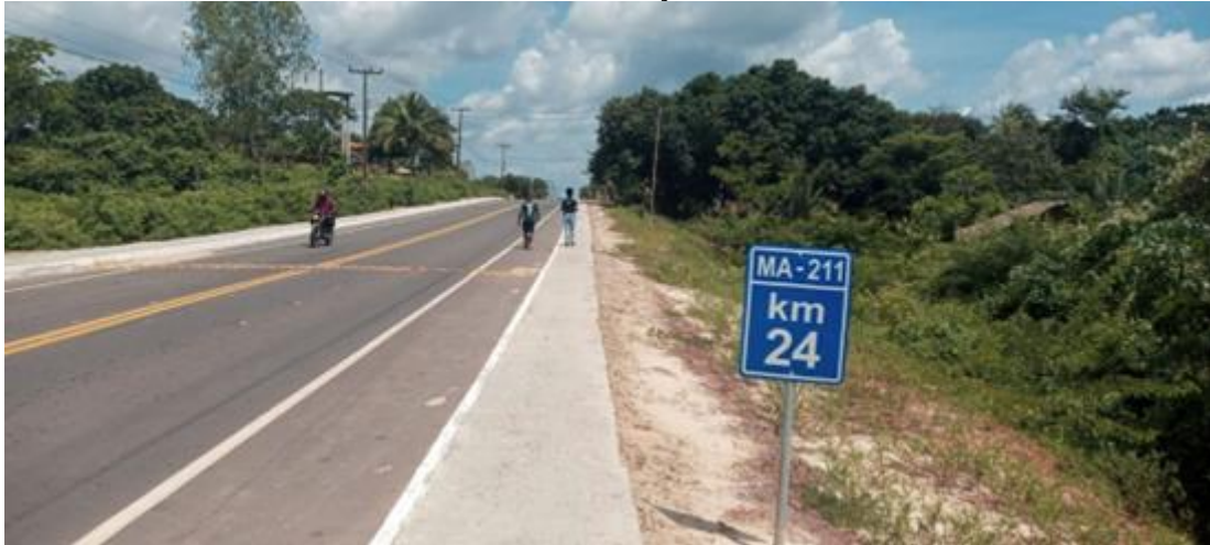
IMAGEM 4: Pavimentação Asfáltica da MA-211
