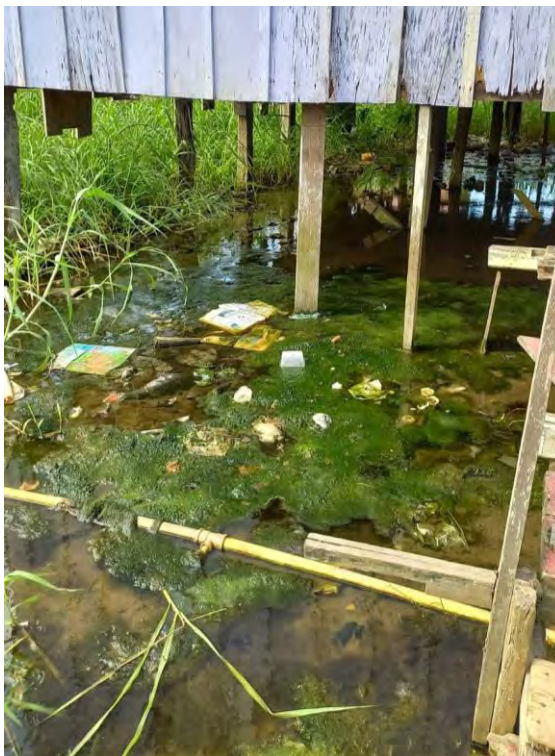
Imagem 2- Falta de saneamento na localidade do Portinho
