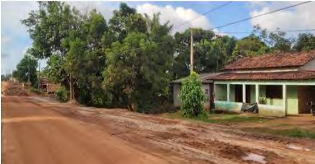
IMAGEM 3: Efeito da construção da rodovia MA-211 sobre as moradias
