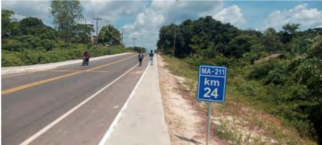
IMAGEM 4: Pavimentação Asfáltica da MA-211
