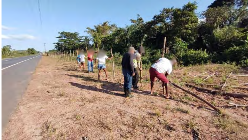
IMAGEM 9: Derrubada da cerca
